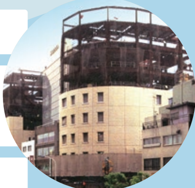
ユニマット青山ビル建築現場
